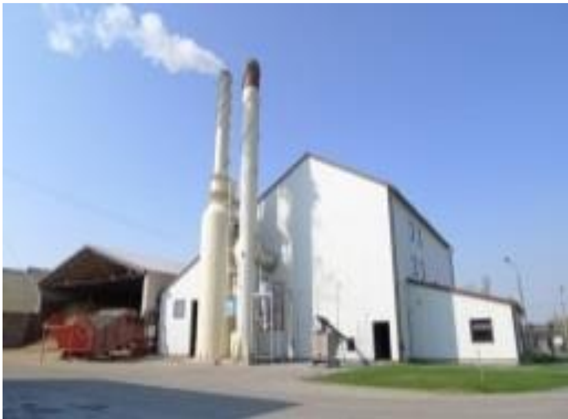
Ludzas biomasas TEC ar dūmgāzu kondensatoru
