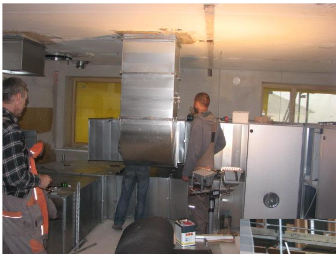
Ventilācijas izbūve 5.stāvā
