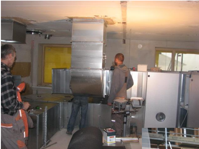
Ventilācijas izbūve 5.stāvā
