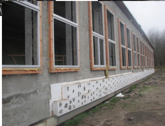
Logu rāmju montāža, siltināšana ar 200mm putuplastu
