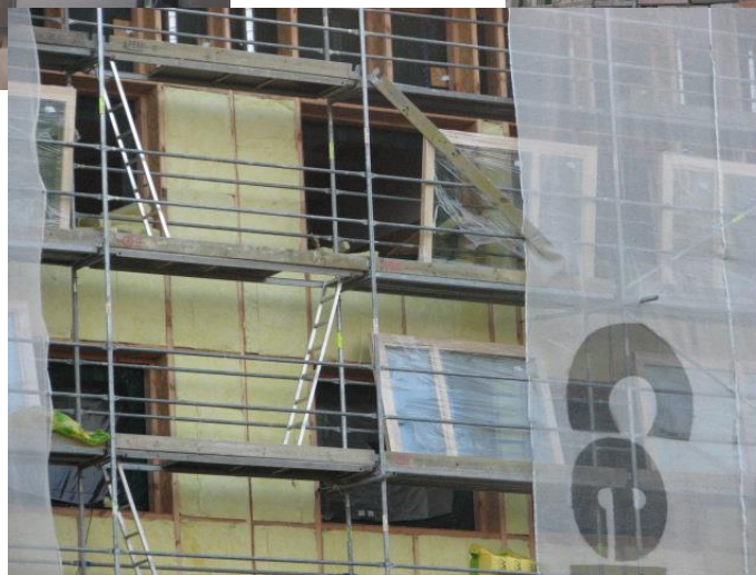
Logu likšana, siltināšana ar minerālvati
