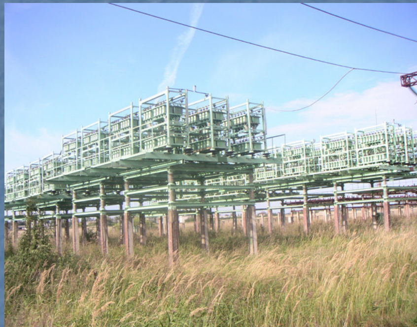
Nolietotās, PHB saturošās kondensatoru baterija
